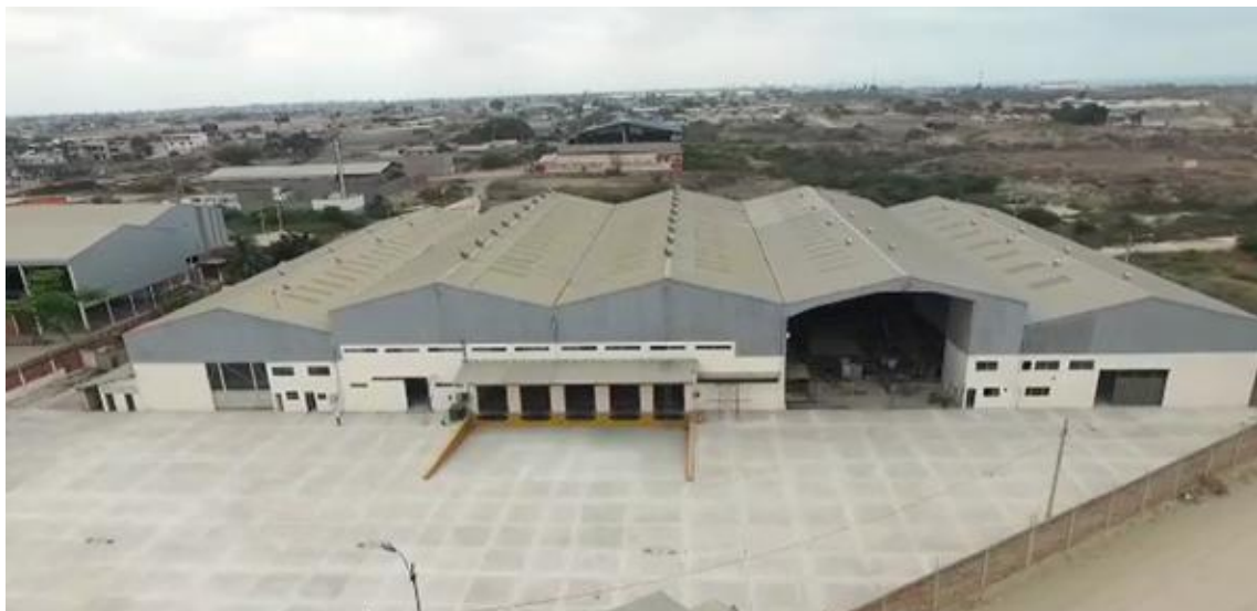
Ilustración 4. Instalaciones de la Factoría Naval
